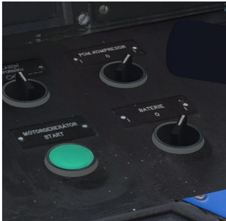
Obrázek 3 - zapnutí pomocného kompresoru
